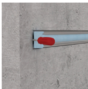
2.) Après le séchage, la mousse de remplissage dans le rail doit être retirée à l'aide d'un outil approprié
