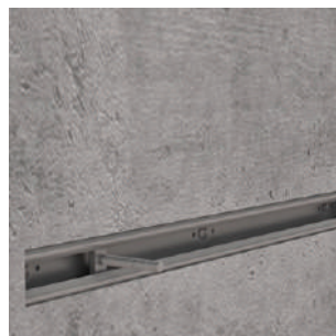
6.) Le verrouillage se fera en le tournant de 90°. L'encoche sur la tige du boulon doit être perpendiculaire au rail
