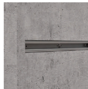
4.) Il ne doit pas rester de résidu de mousse ou de béton dans la rainure du rail. Tout résidu doit être enlevé
