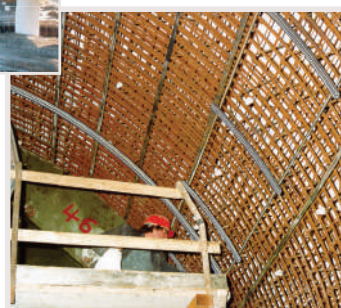
Rails d'ancrage droits ou cintrés utilisés dans la construction de tunnels ou de ponts
