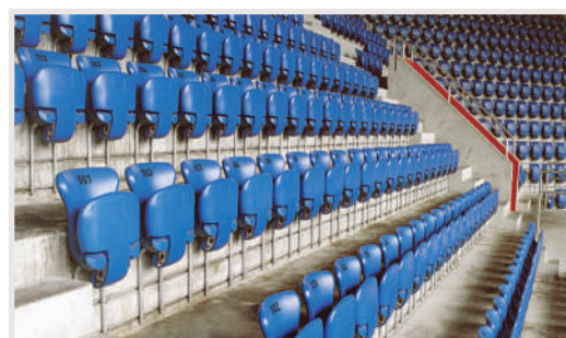
Sièges de stade fixés sur des rails d'ancrage
