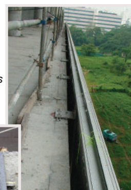
Façade fixées sur des rails d'ancrage sur le dessus de la dalle
