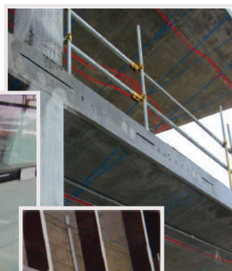
Façade en verre fixée sur des rails d'ancrage en bord de dalle
