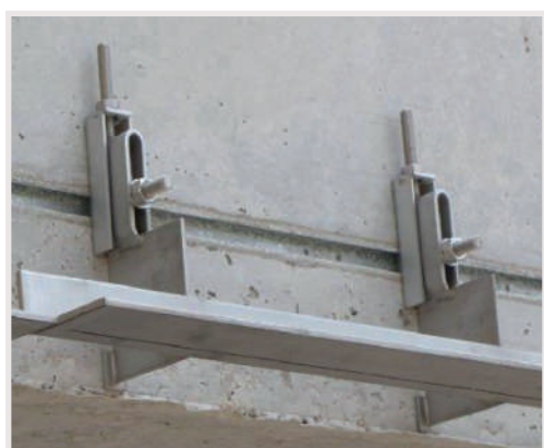
Façade de briques fixée sur des rails d'ancrage
