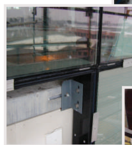
Façade en verre fixée sur des rails d'ancrage en bord de dalle
