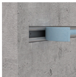
3.) La mousse peut être retirée le long du rail simplement à la main
