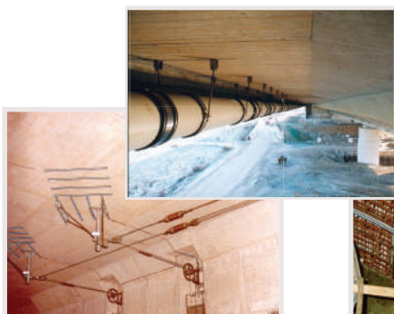
Rails d'ancrage droits ou cintrés utilisés dans la construction de tunnels ou de ponts
